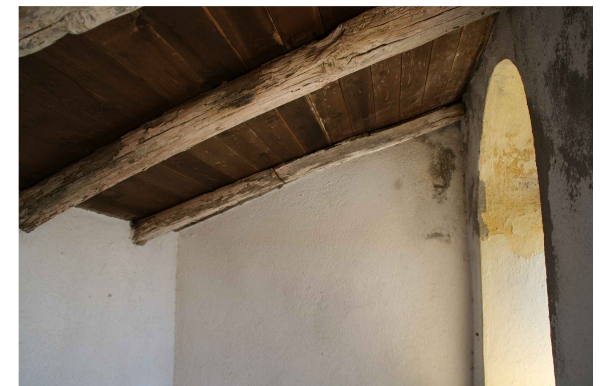
Interno della torre campanaria.
